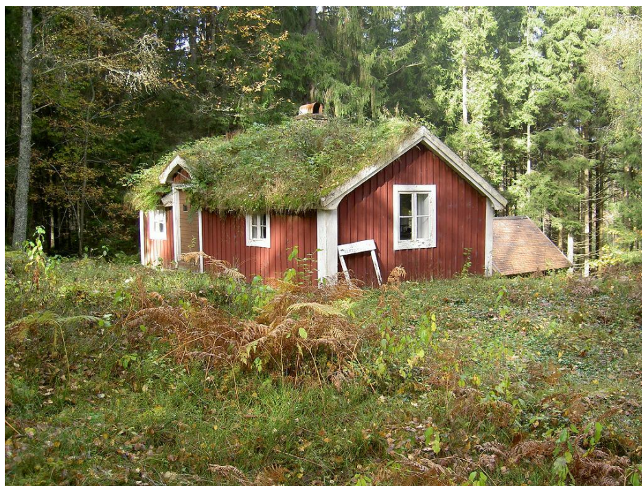
Stugan innan den stora utvändiga renoveringen 2017. Bilden tagen år 2011.
