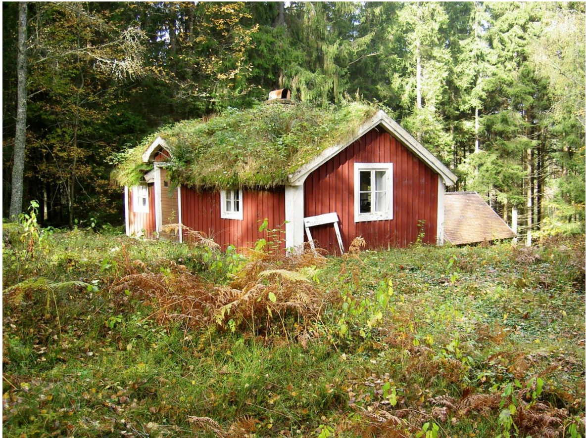
"Kålla-Haukene- Stu'an" utifrån år 2011. Omfattande tak- och fasadrenoveringar har utförts år 2016.
