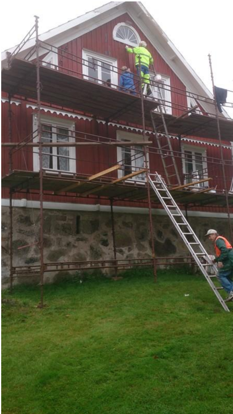
Det gick åt mycket byggnadsställningar på norrsidan och några stegar för att komma högst upp.
