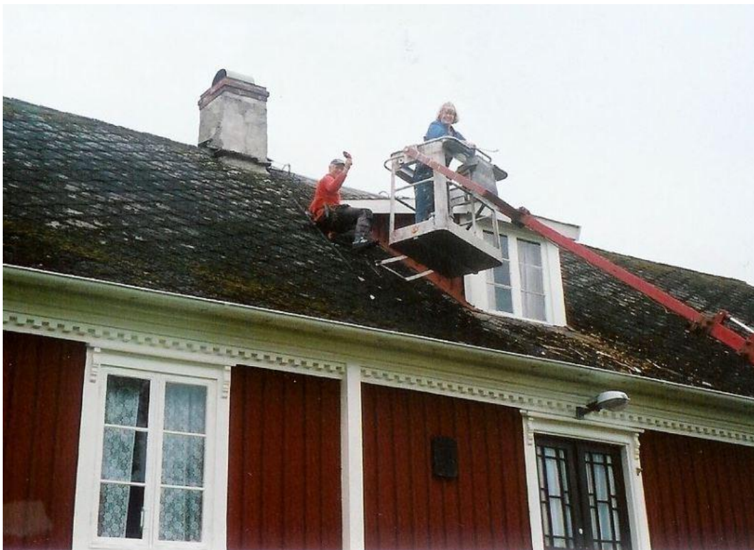
Ingen rädder för höjder här! Kalle och Ingrid fixar till och målar utbygget på taket.
