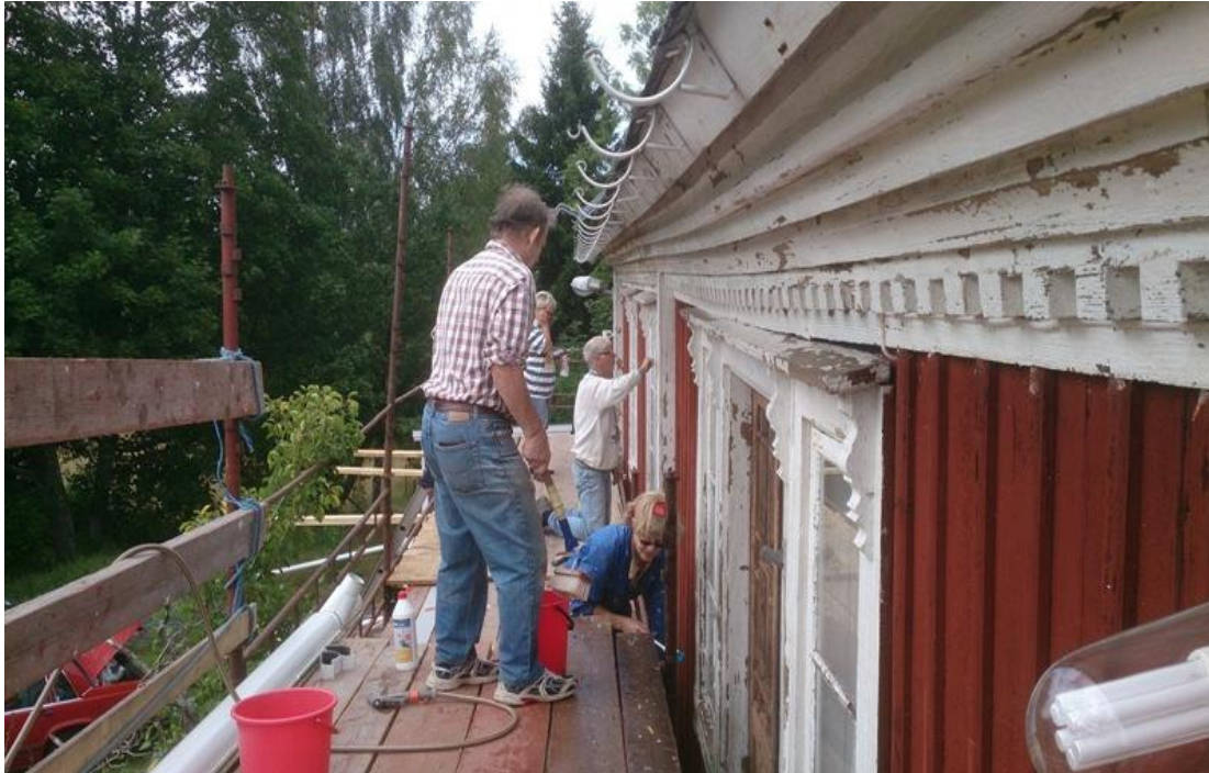
Det gick åt mycket tid åt att skrapa och tvätta. Här jobbas det med västra långsidan.
