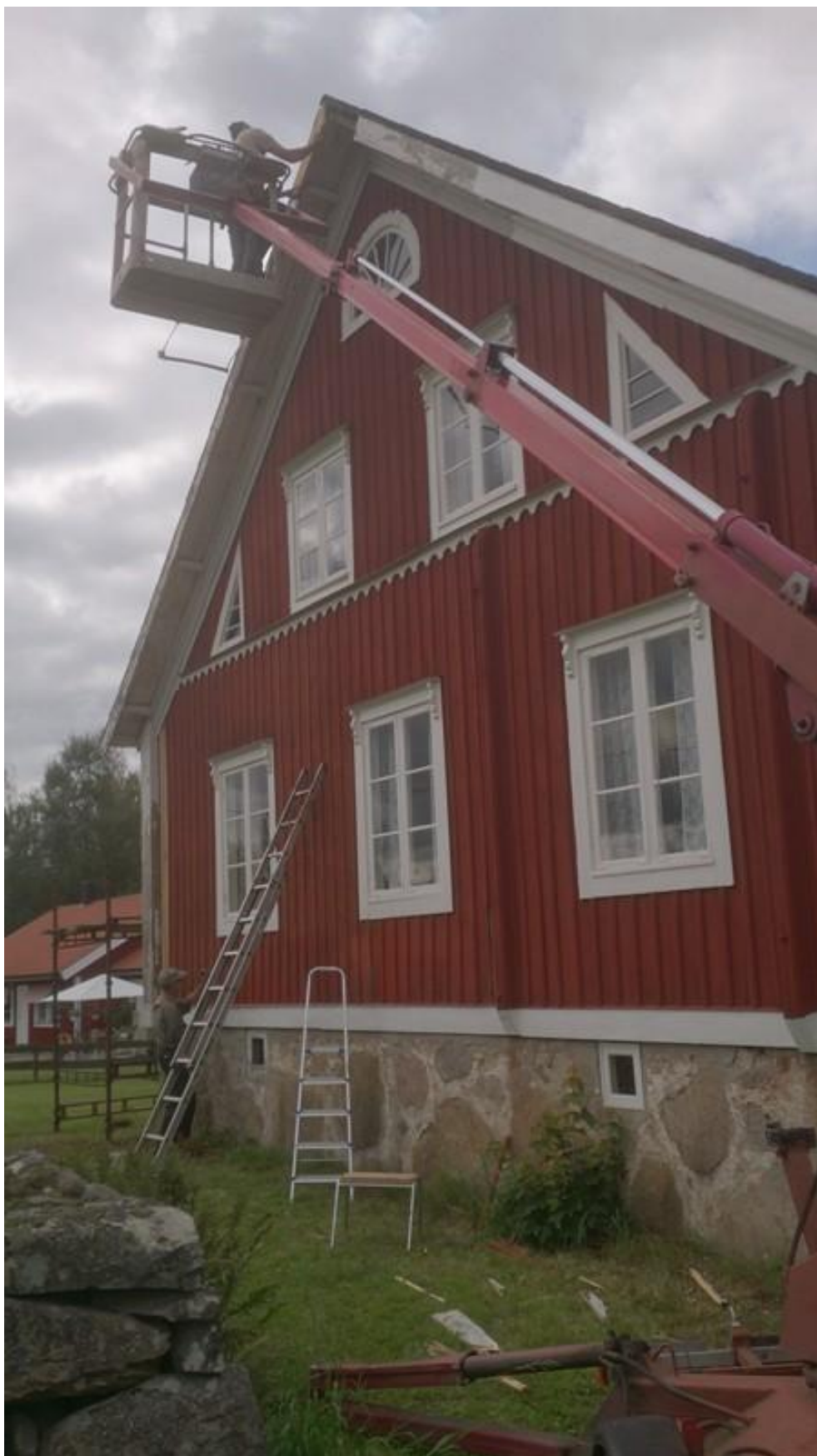
Kalle byter en dålig vindskiva på södergaveln. Då är det praktiskt med en lift. Under tiden målar Lars Berg rödfärg på betydligt lägre höjd.
