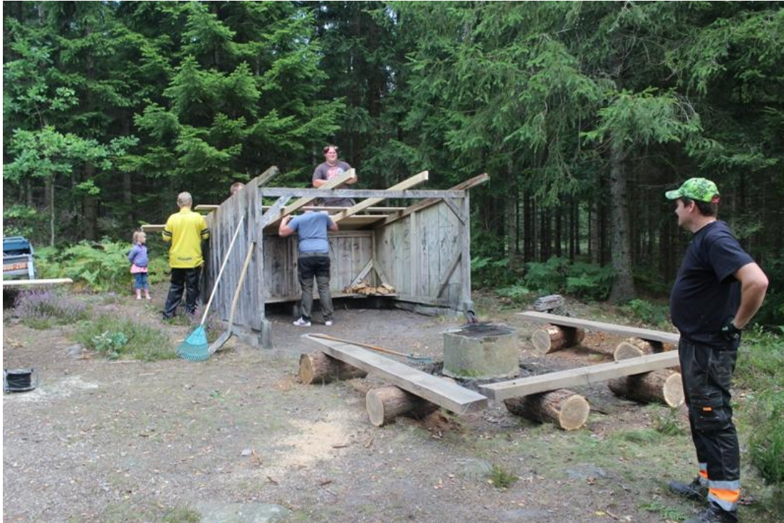
Nytt tak är på gång. Grillrör och sittplatser fixade. Är Henrik arbetsledare !!!!
