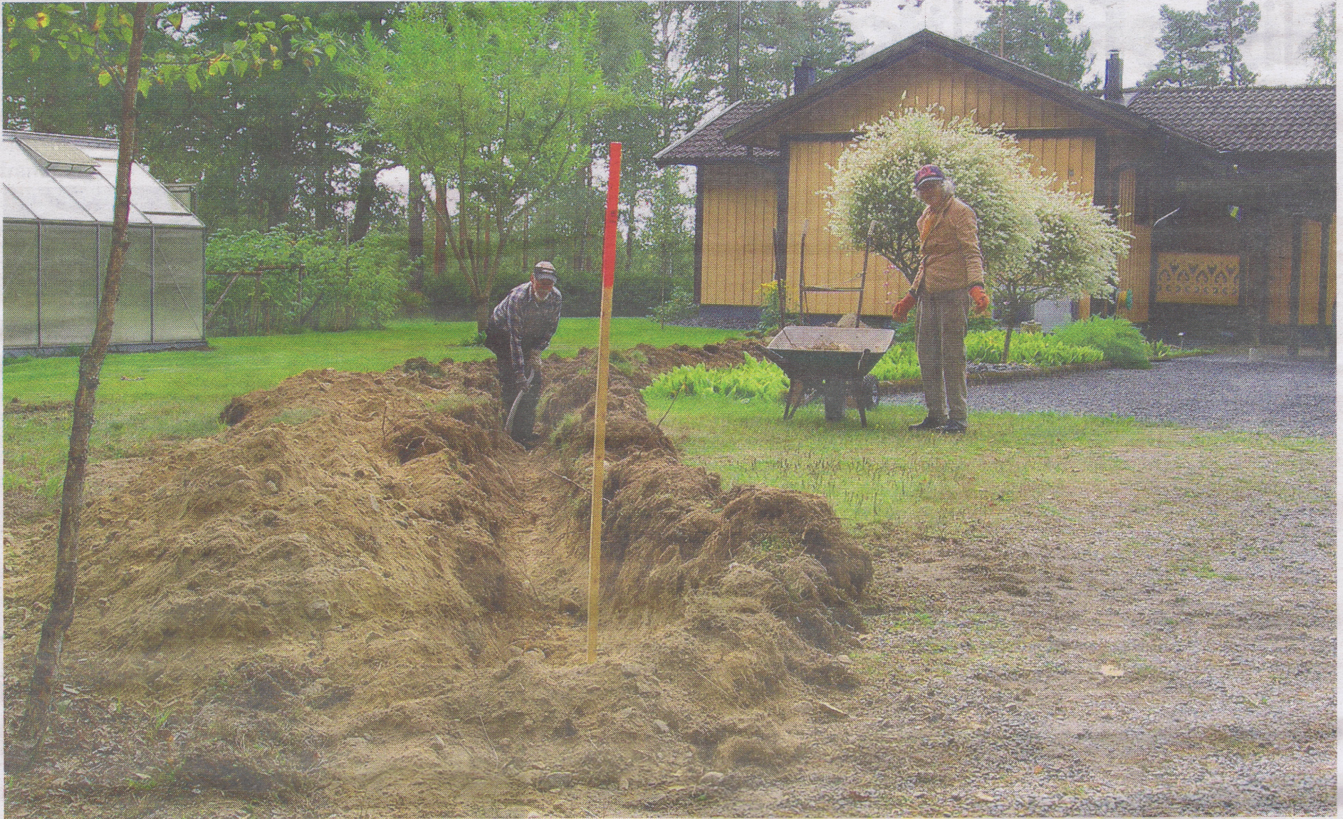
Pensionärsparet Sture Hansson och Maj-Britt Karlsson förbereder sig för bredbandet. En minigrävare har tagit upp ett schakt för fiberslang i trädgården och nu putsar de botten och kör bort sten.
