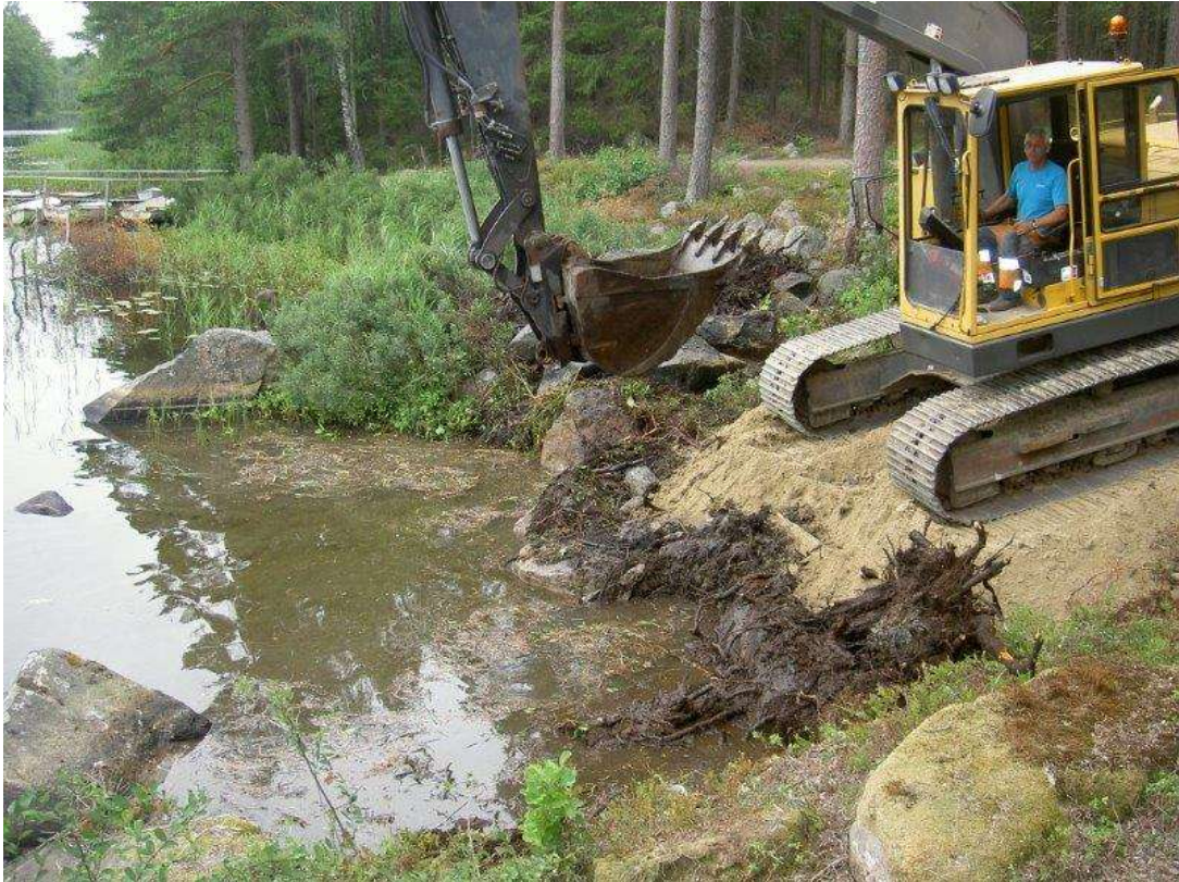
"Slobbet" grävs bort för att få en fast botten till mini-badstranden.
