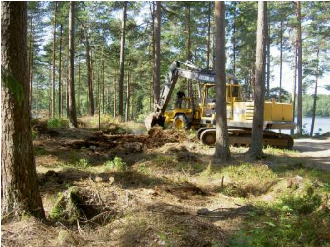
Vegetationslager och ytsten banas av för utökade parkeringsområden.
