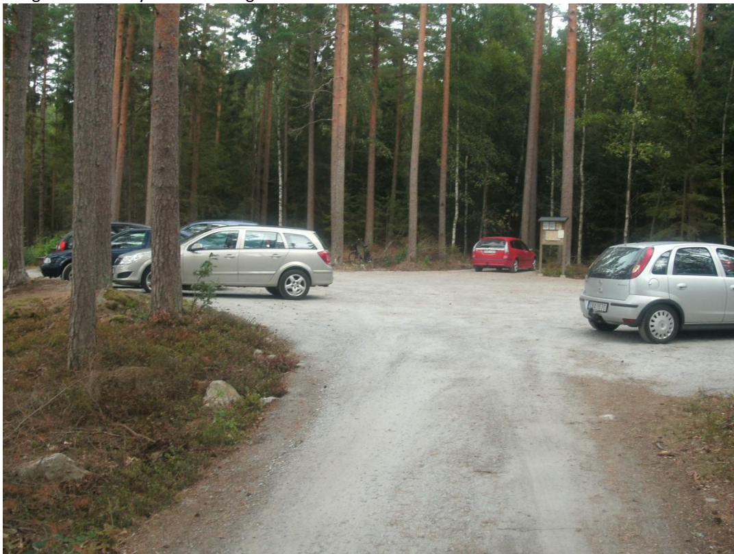
De nyanlagda parkeringsplatserna, instuckna mellan tallarna, kom väl till pass.
