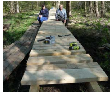
80 m spång byggts
