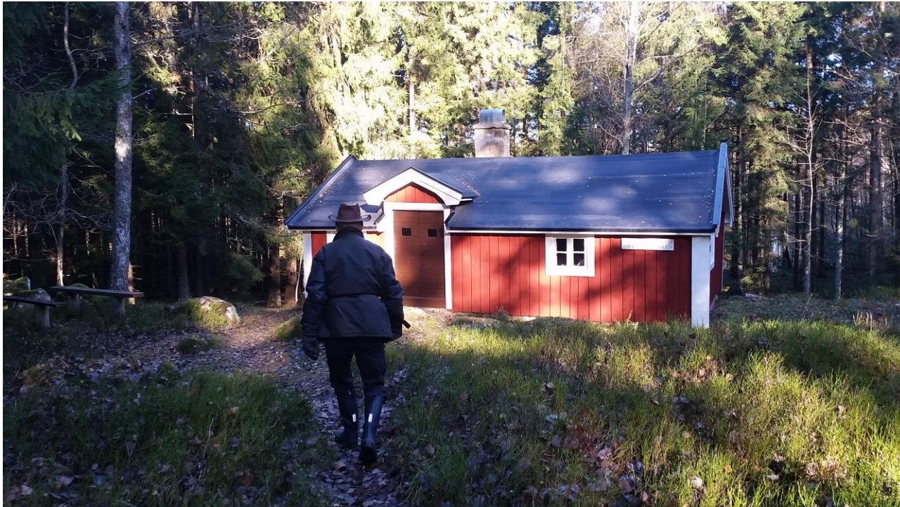
Sture "stövlar på" med bestämda steg mot den nyrenoverade stugan- nymålad med nytt papptak.
