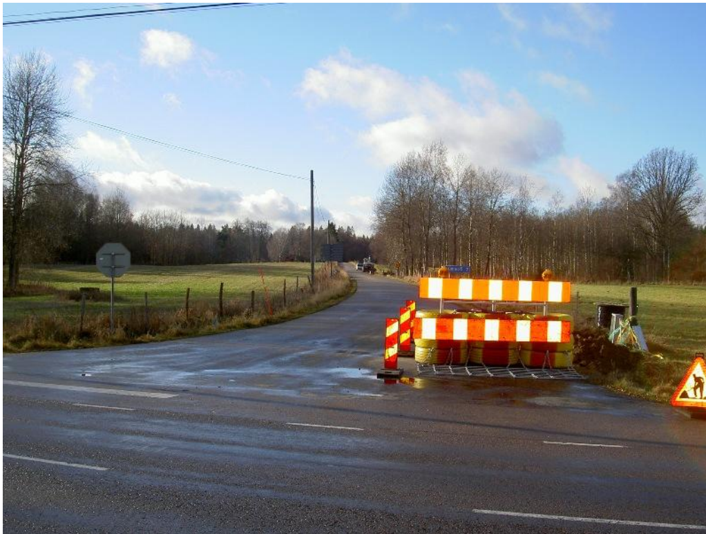
Schaktning pågår längs Slänsmålavägen i Kullemåla.
