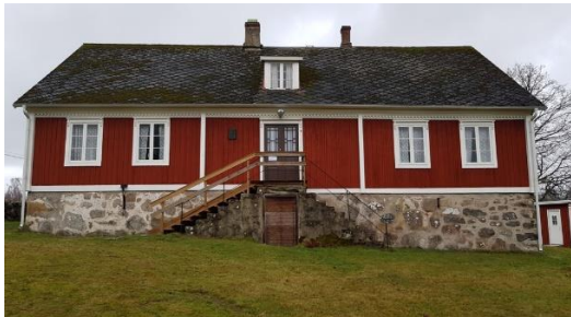
Mangårdsbyggnad, långsida mot öster
