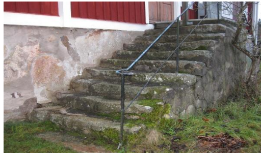
Befintlig stentrappa, långsida mot väster
